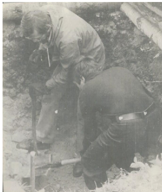
Начальник экспедиции В.Ф. Синьков и лаборант Г.Н. Вантеев готовят «блиндаж» для установки обсерватории ИЗМИРАН-4. Необходимость установки магнитометров в такие укрытия связана со стремлением избежать больших колебаний температуры на магнитах-индикаторах
